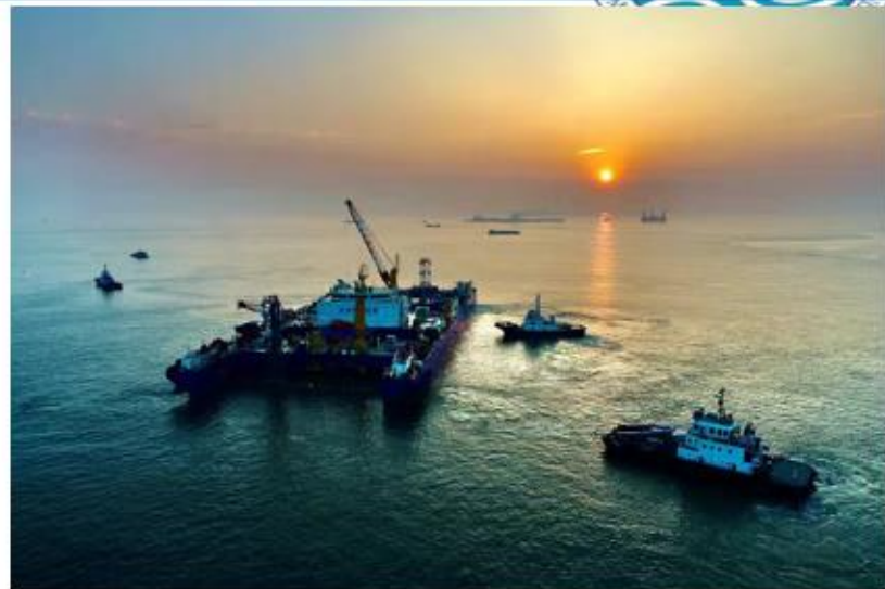
中交一体船沉管安装
